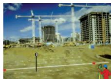
建築工地的軸線放樣和竣工檢查
